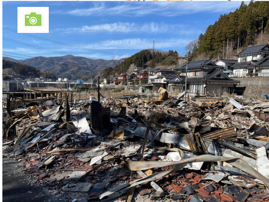
B-2 周囲に延焼した跡がない
